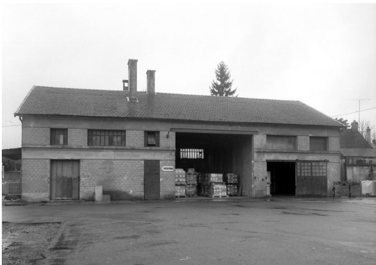
Salle des machines, façade latérale nord.
