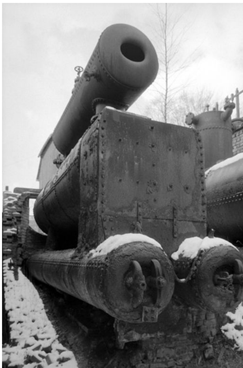
Chaufferie, chaudière à vapeur (Louis Fontaine).
