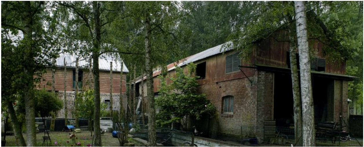
Vue d'ensemble d'une des dépendances agricoles façade sur cour.
