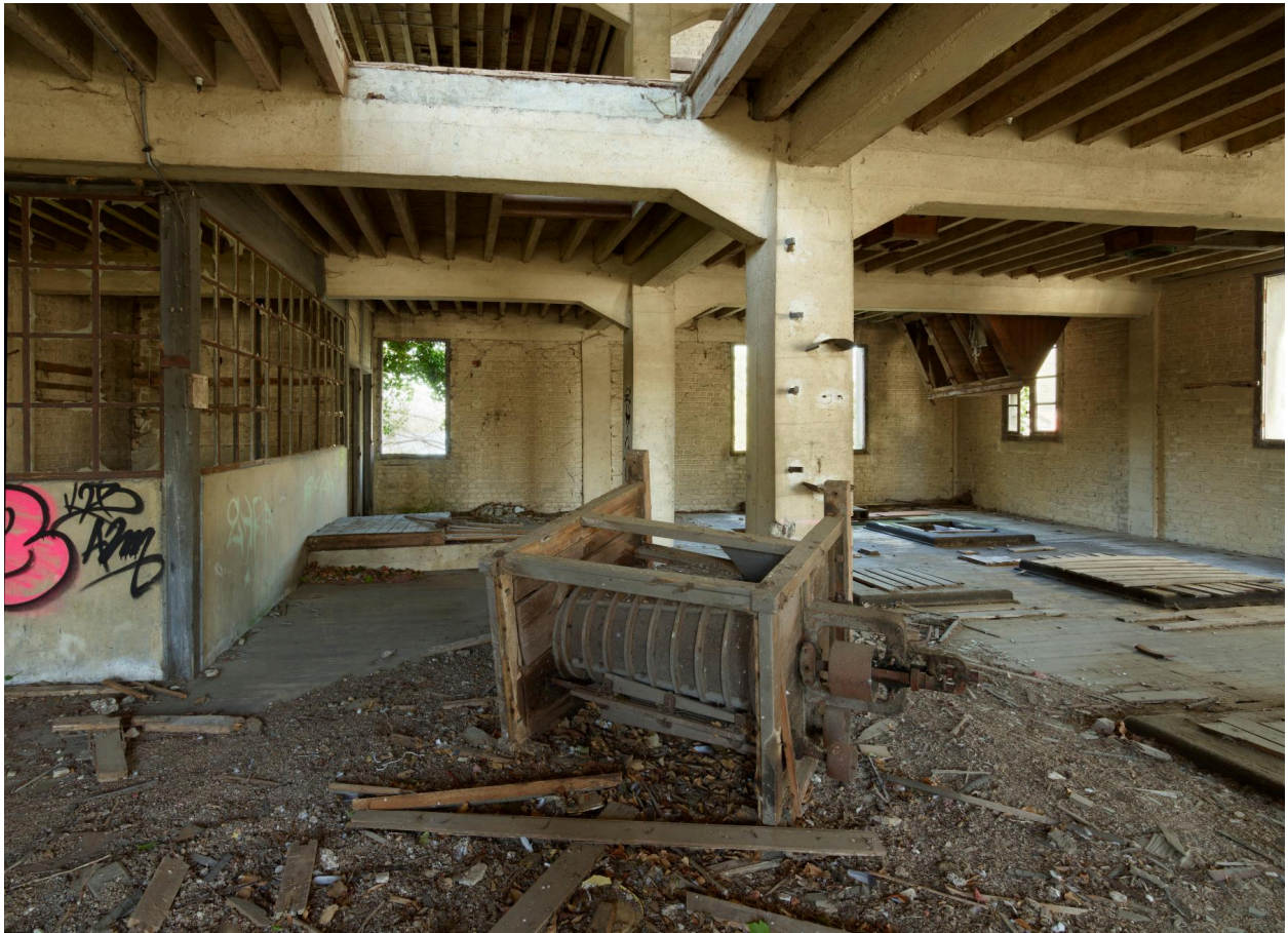
Intérieur du deuxième étage de la minoterie.
