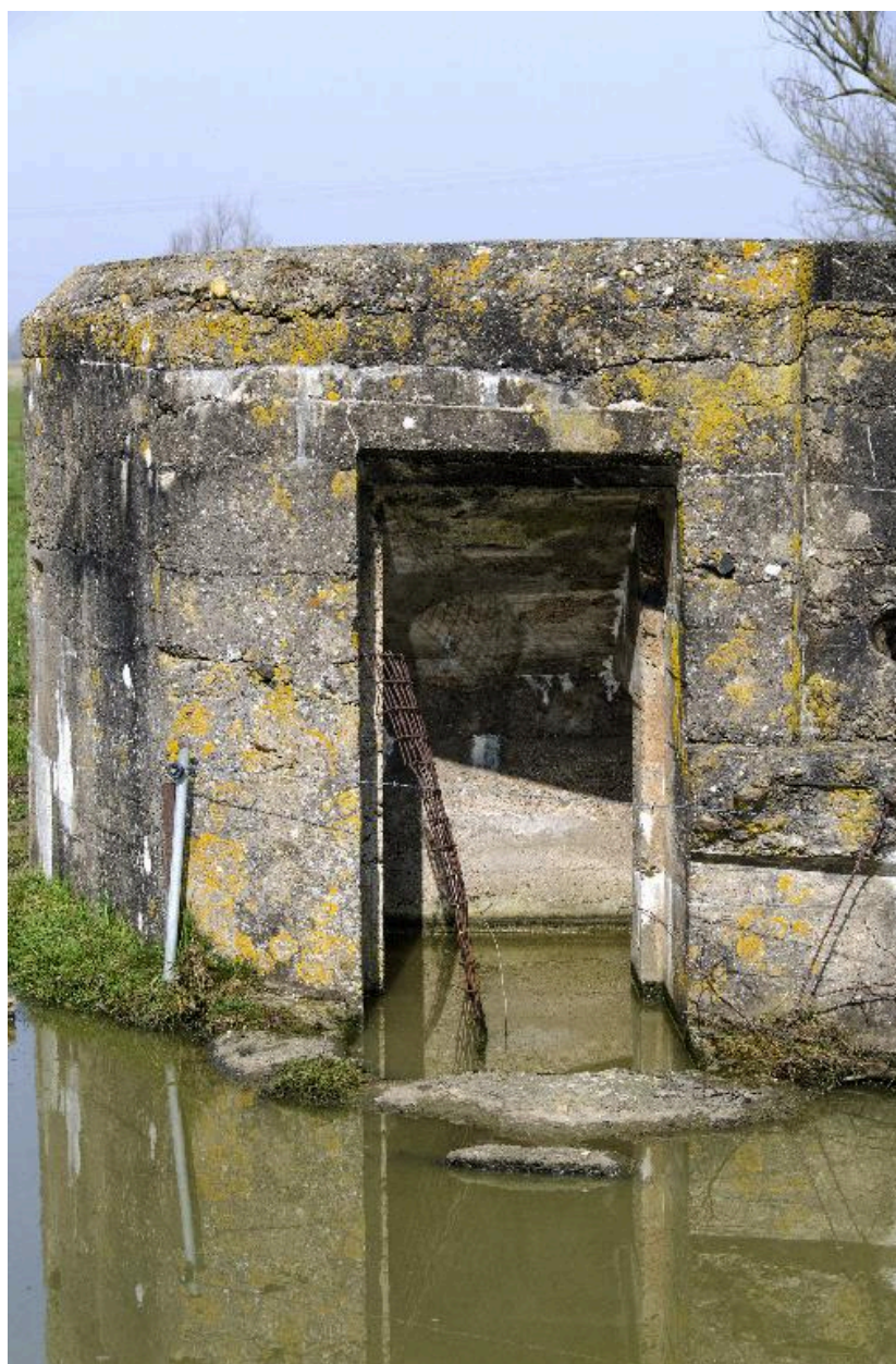
Elévation sud, entrée ouest
