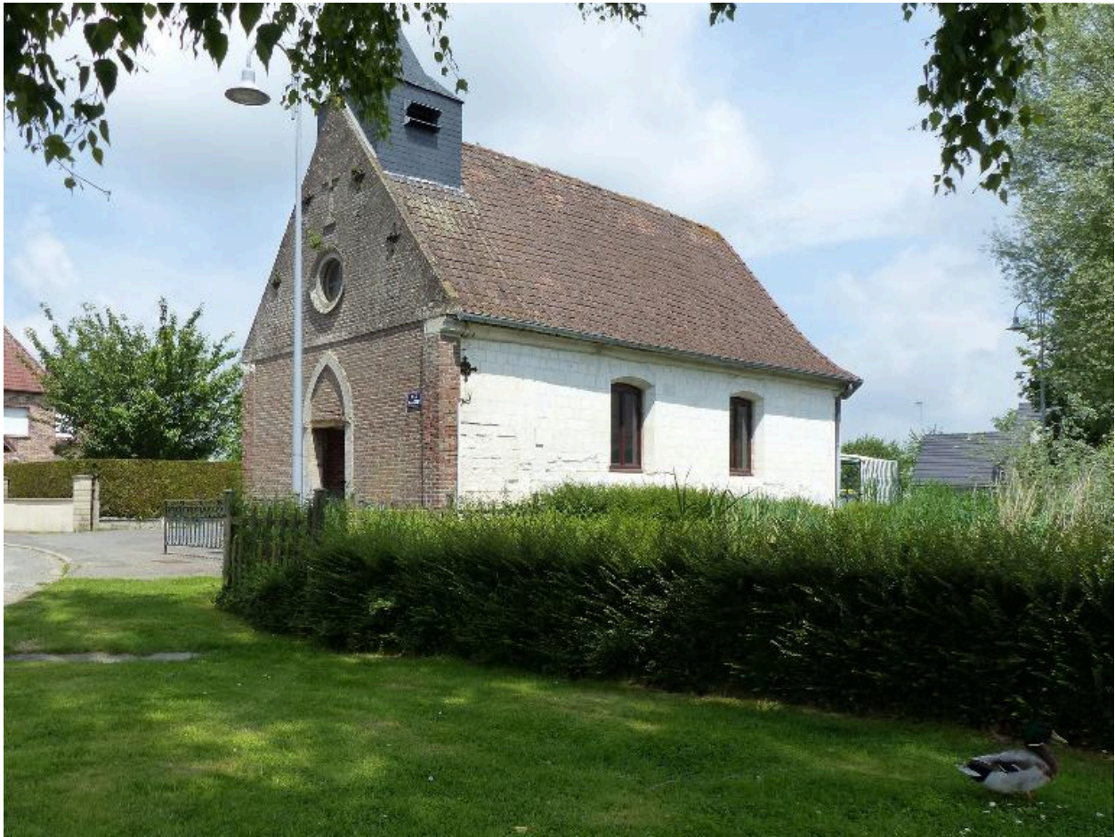
Vue de situation, depuis la place.
