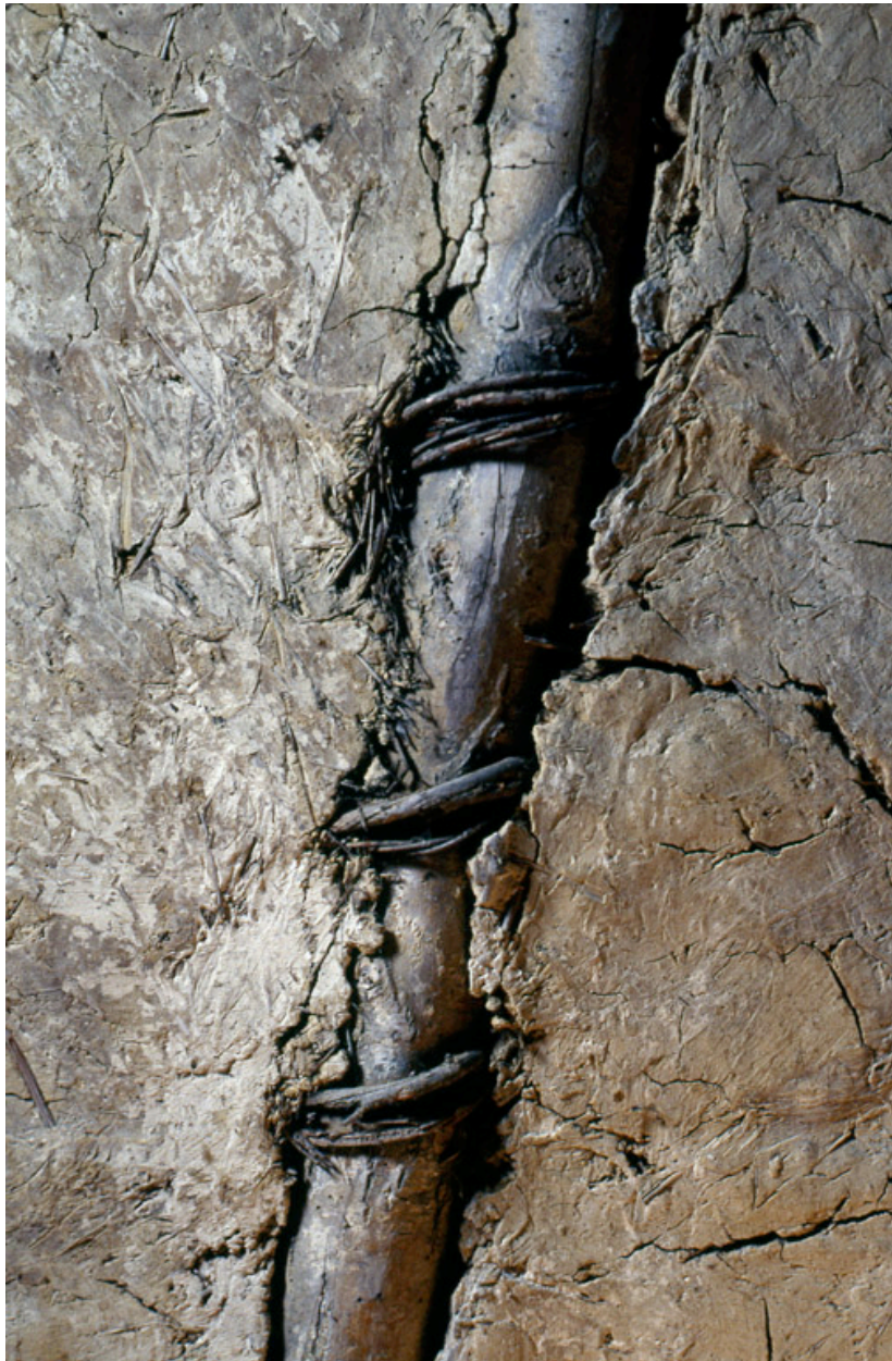
Barzy-en-Thiérache, ferme (repérée), 30 rue Neuve : détail d'une cloison en torchis dans le comble du logis.
