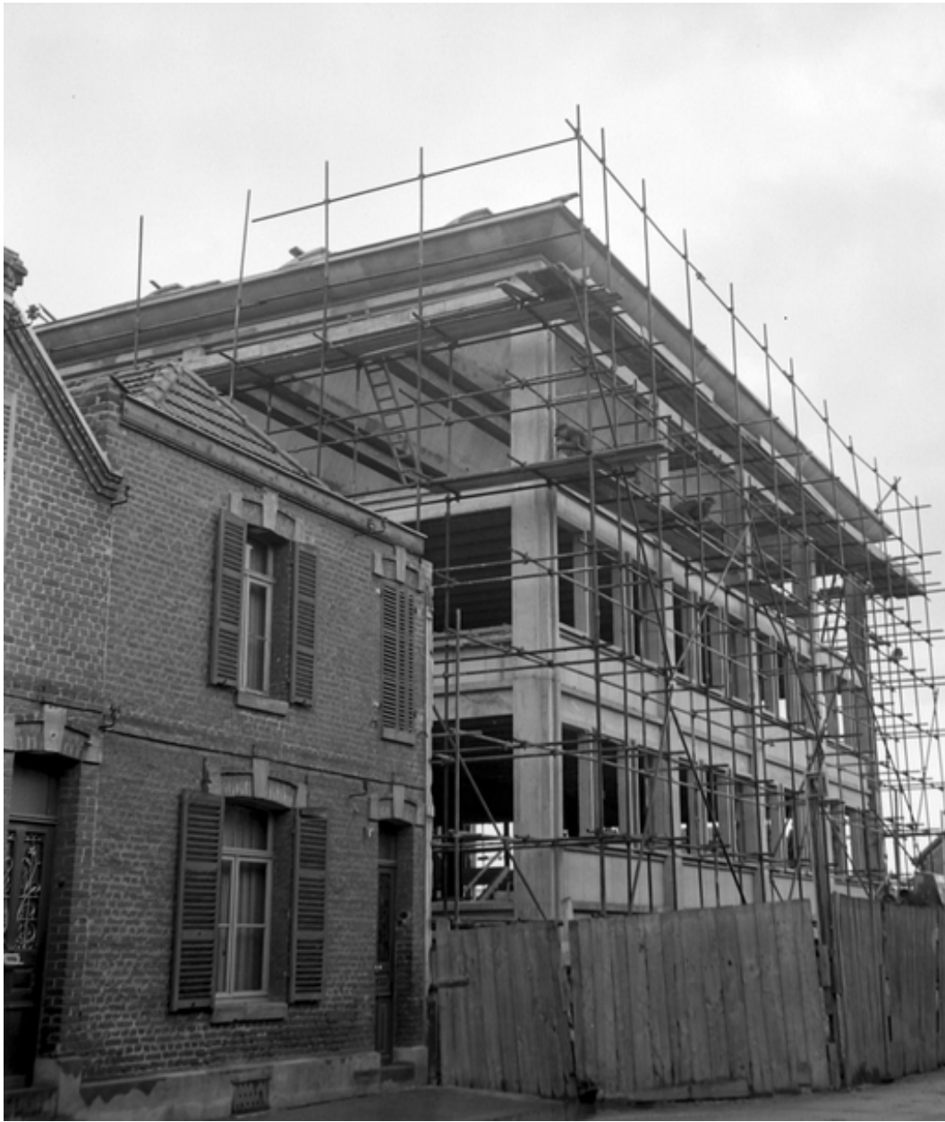
Les services généraux en construction, vers 1950 (IFA).
