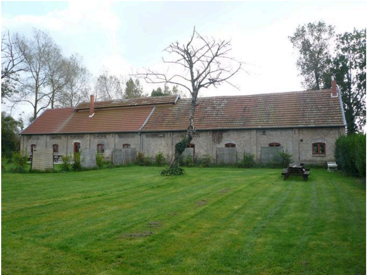
Vue de la cossetterie à l'est de la propriété.
