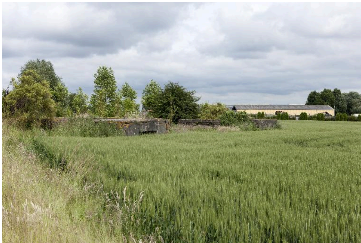
Vue générale vers le nord-est
