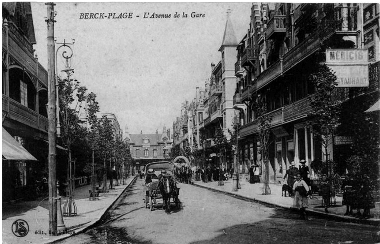
Vue générale vers la gare, carte postale ancienne, date inconnue.
