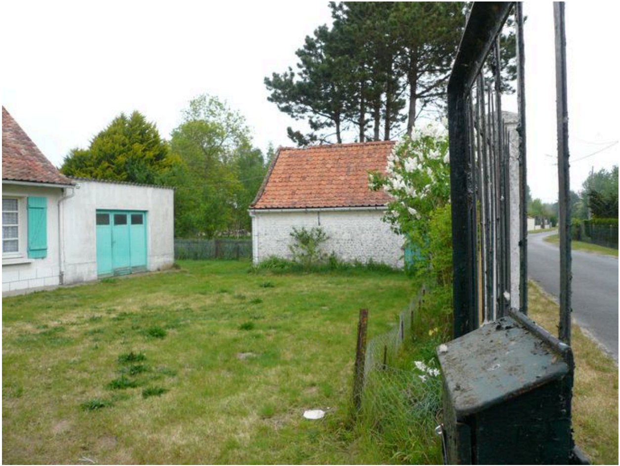
Vue du bâtiment annexe.
