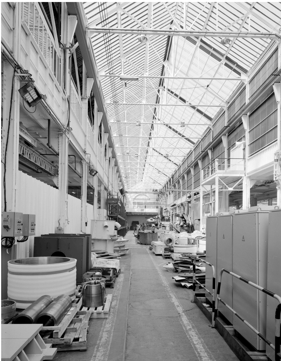
Vue générale de la halle 7 nord : atelier de moyenne mécanique.
