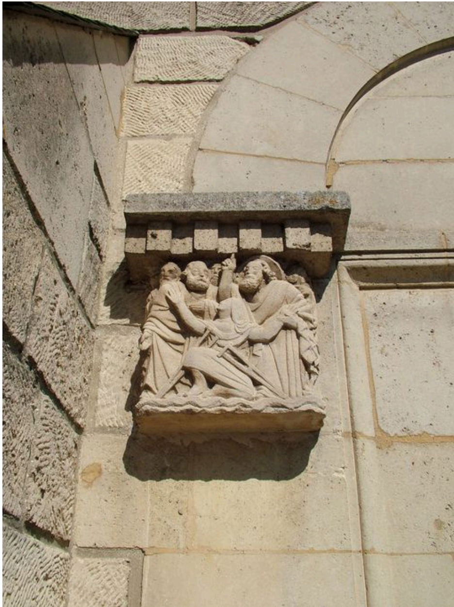
Vue du chapiteau de la porte sud présentant saint Pierre rendant miraculeusement la santé à une paralytique.
