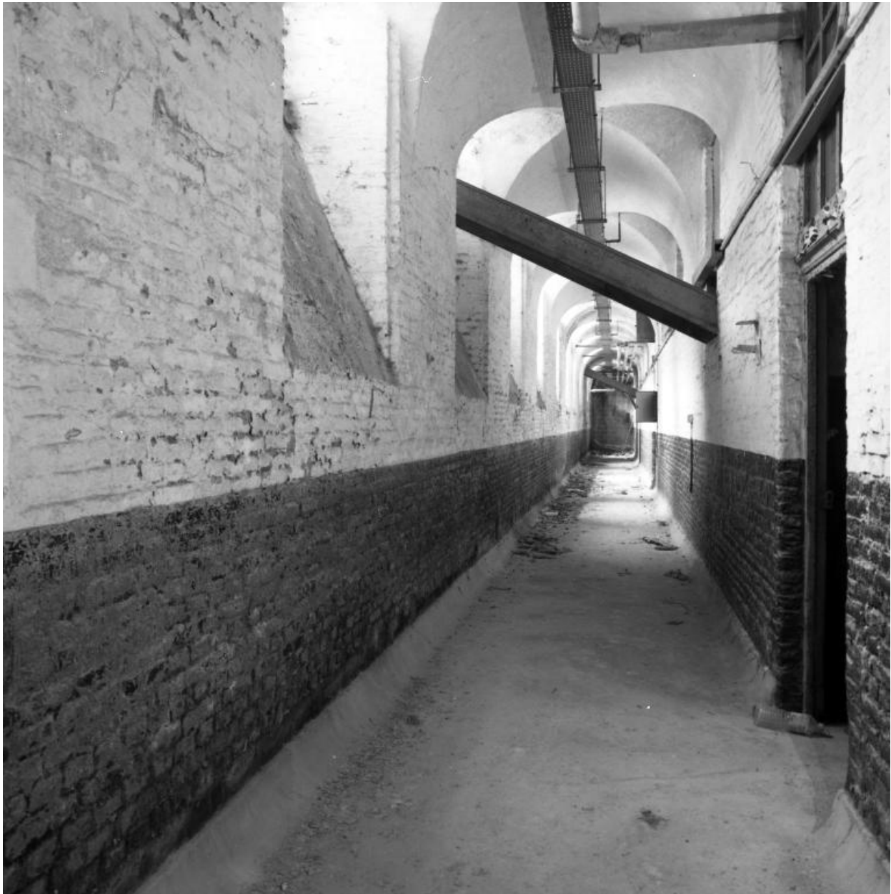
Sous-sol, galerie de distribution d'un des bâtiments bordant la cour d'honneur, vue en enfilade.
