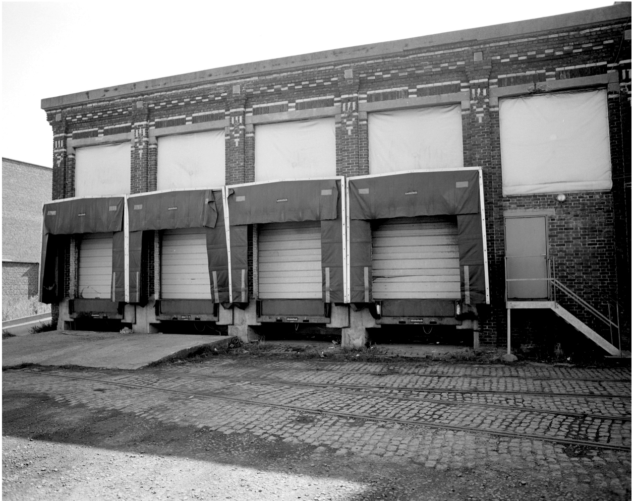
Atelier de fabrication, façade nord-ouest. Poste de chargement.
