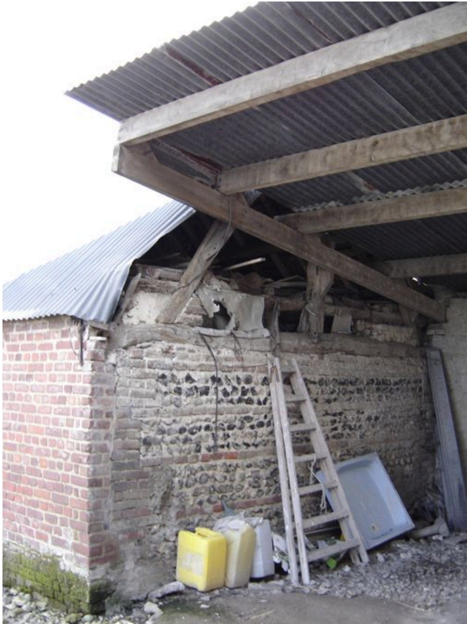
Vue du pignon sur cour de cette remise.
