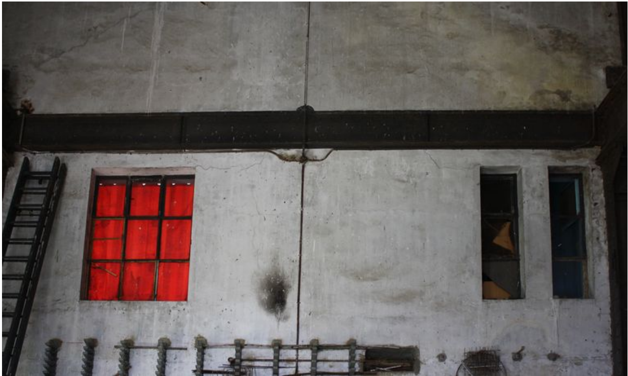
Intérieur de l'atelier de réparation, détail des ouvertures de surveillance, depuis les bureaux.
