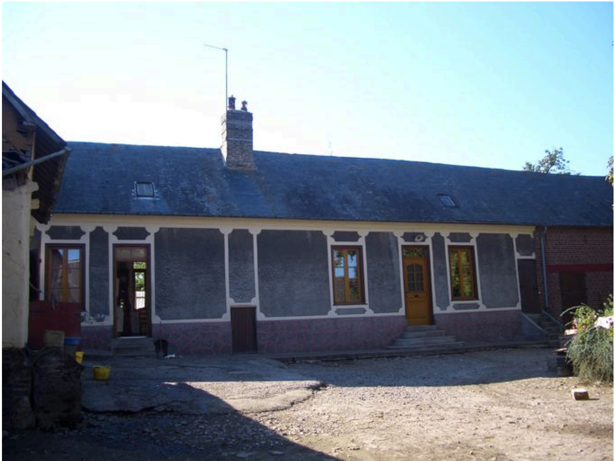
Façade principale du logis.
