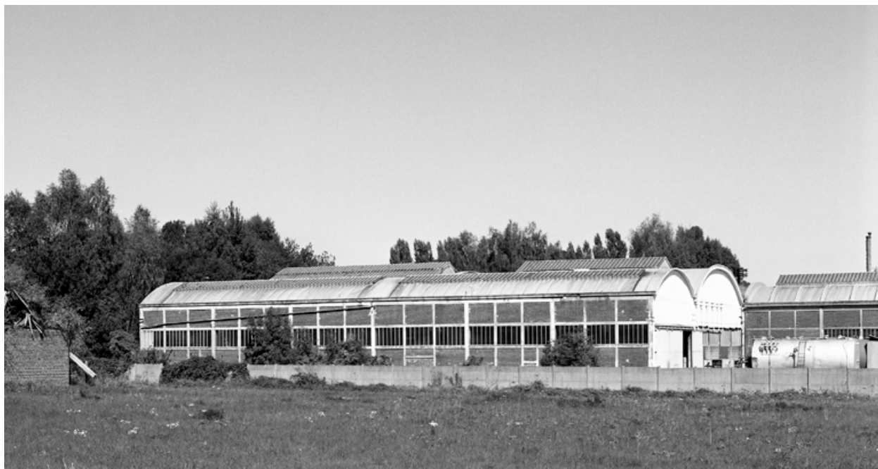
Les ateliers de chaudronnerie construits en 1920, façade ouest.
