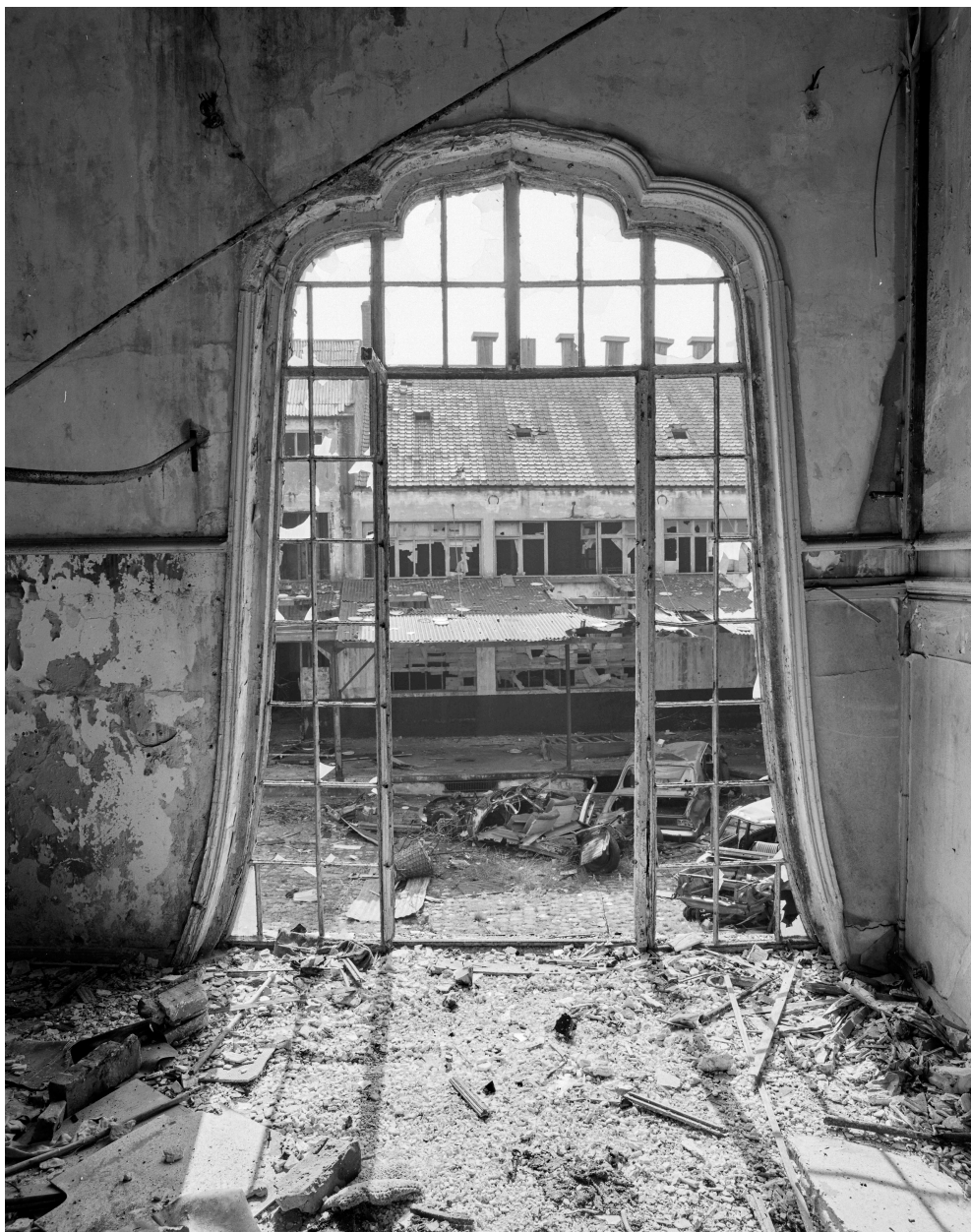
Porte-fenêtre : vue de l'intérieur.
