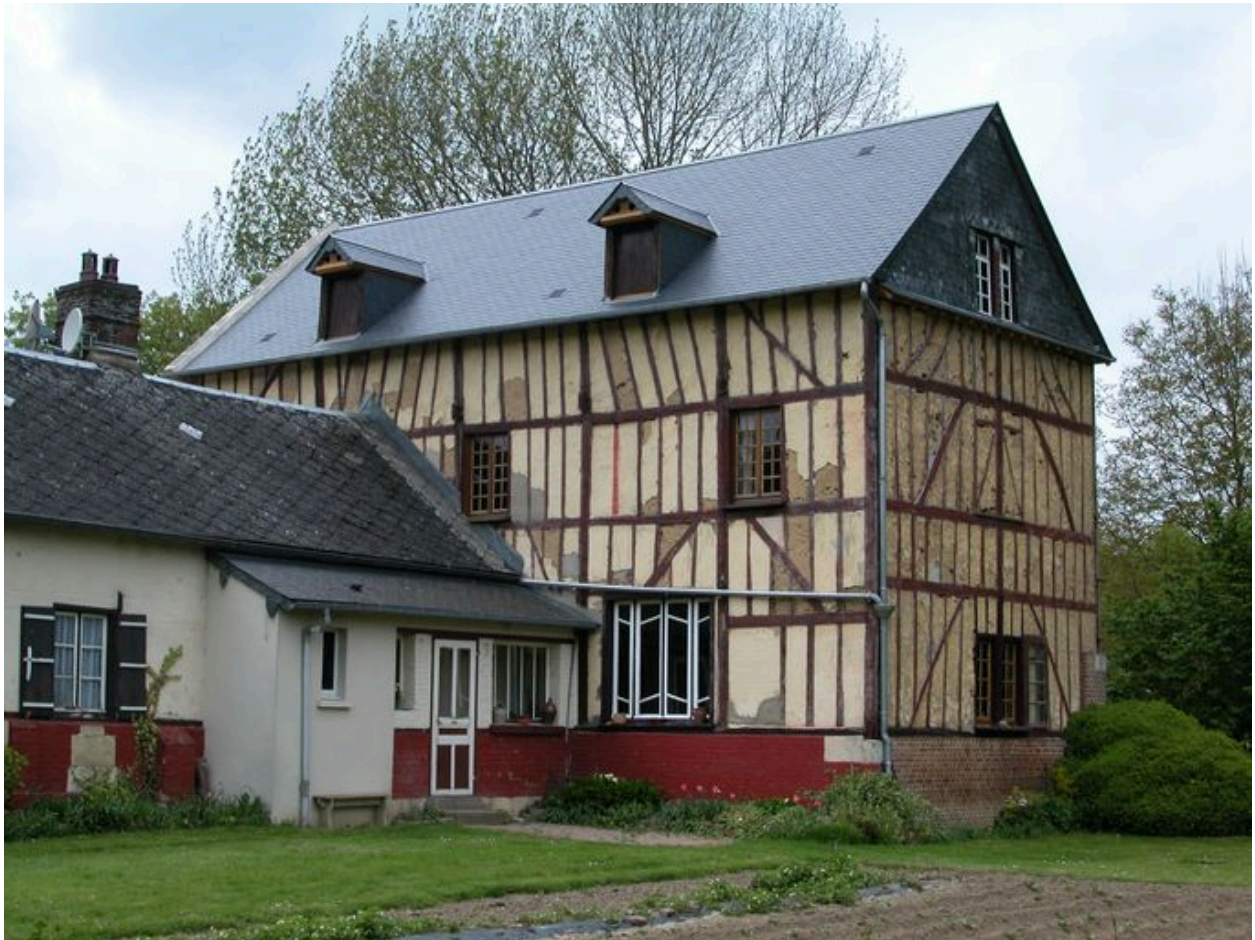
Vue d'ensemble du moulin, façade antérieure.
