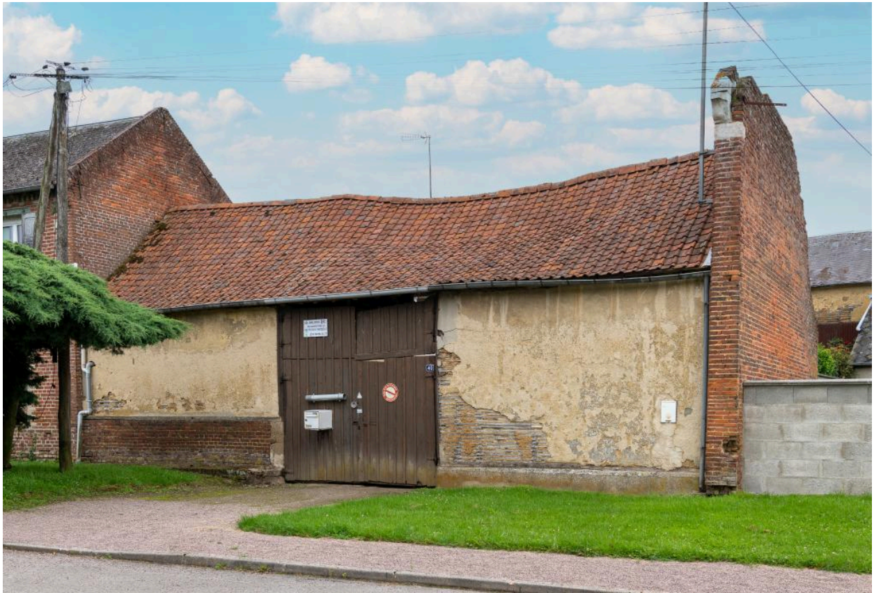
Grange sur rue d'une ancienne ferme, n°40 rue Principale, vue depuis l'est.
