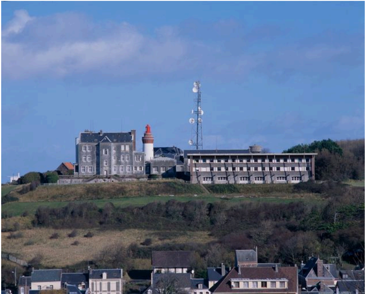
Vue d'ensemble depuis le lotissement du Bel-Air.
