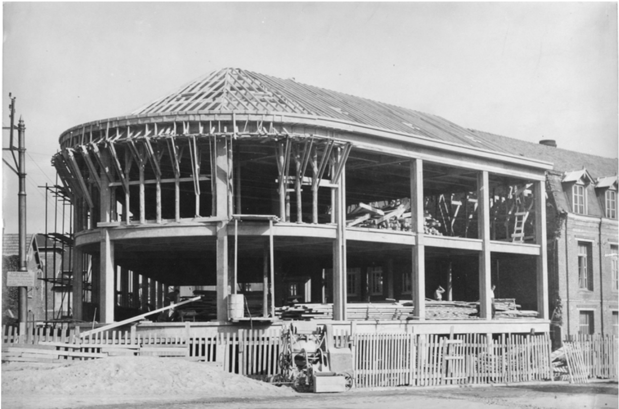
Chantier de construction des ateliers, par Desprey-Pollet, vers 1948 (IFA).
