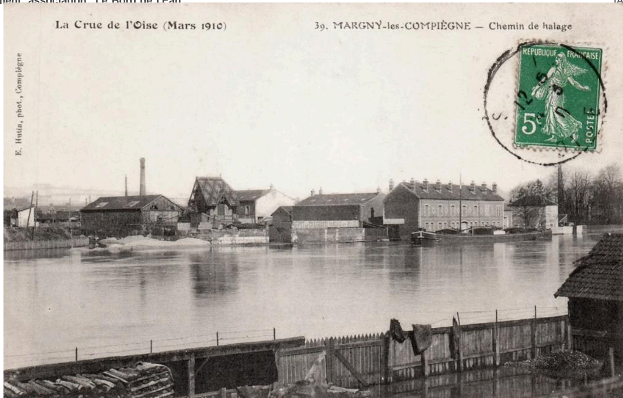
La Crue de l'Oise (mars 1910). 39. MARGNY-les-COMPIEGNE - Chemin de halage. E. Hutin.phot., Compiègne. [photographie en vente sur le site Delcamp.net].
