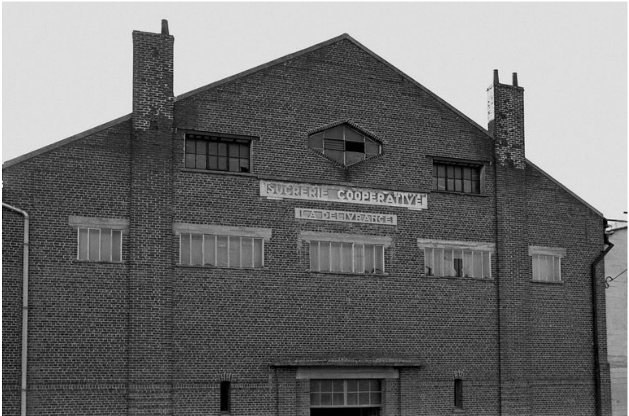
Atelier principal, flanc sud : détail.
