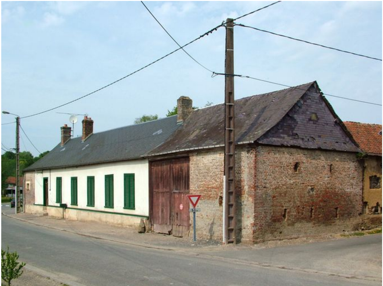
Canaples, ferme, 51 rue de l'Eglise, première moitié du 19e siècle.
