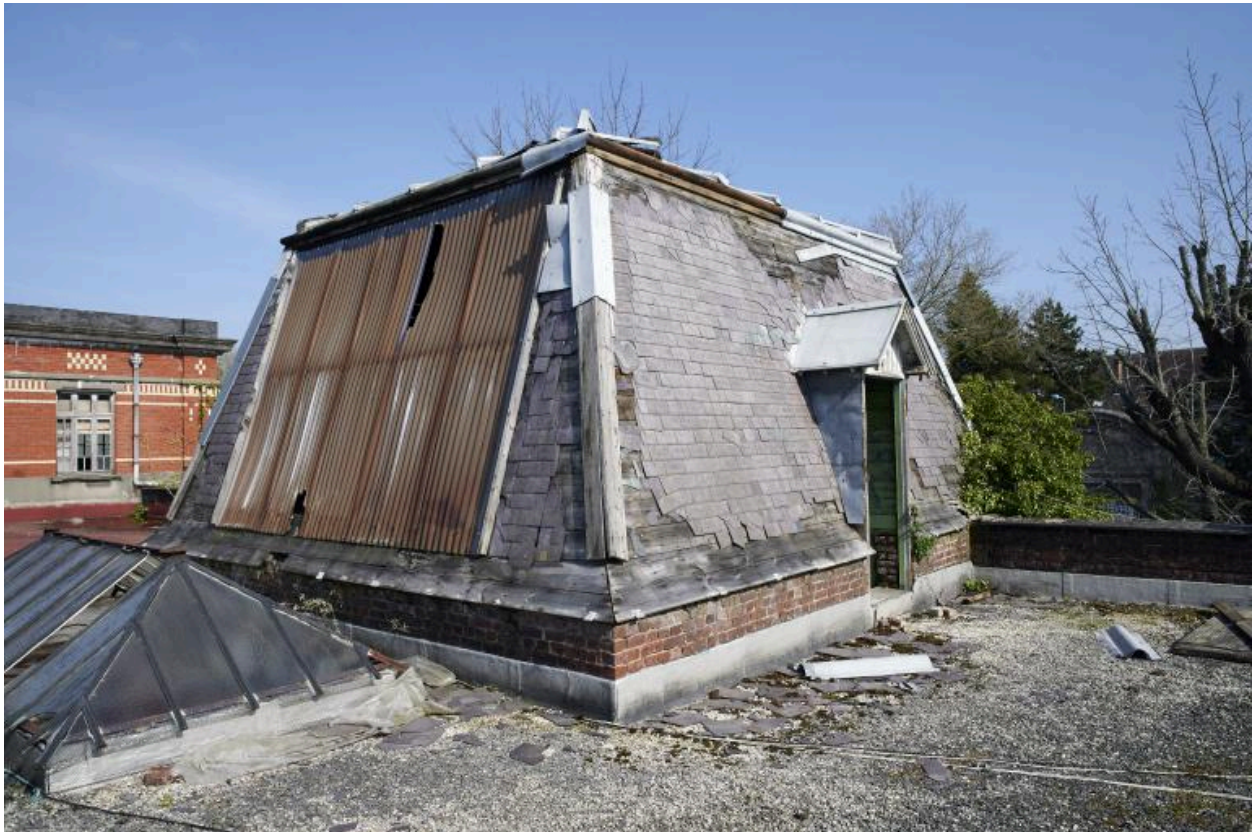
Bureaux. Vue du lanterneau depuis le couverture.
