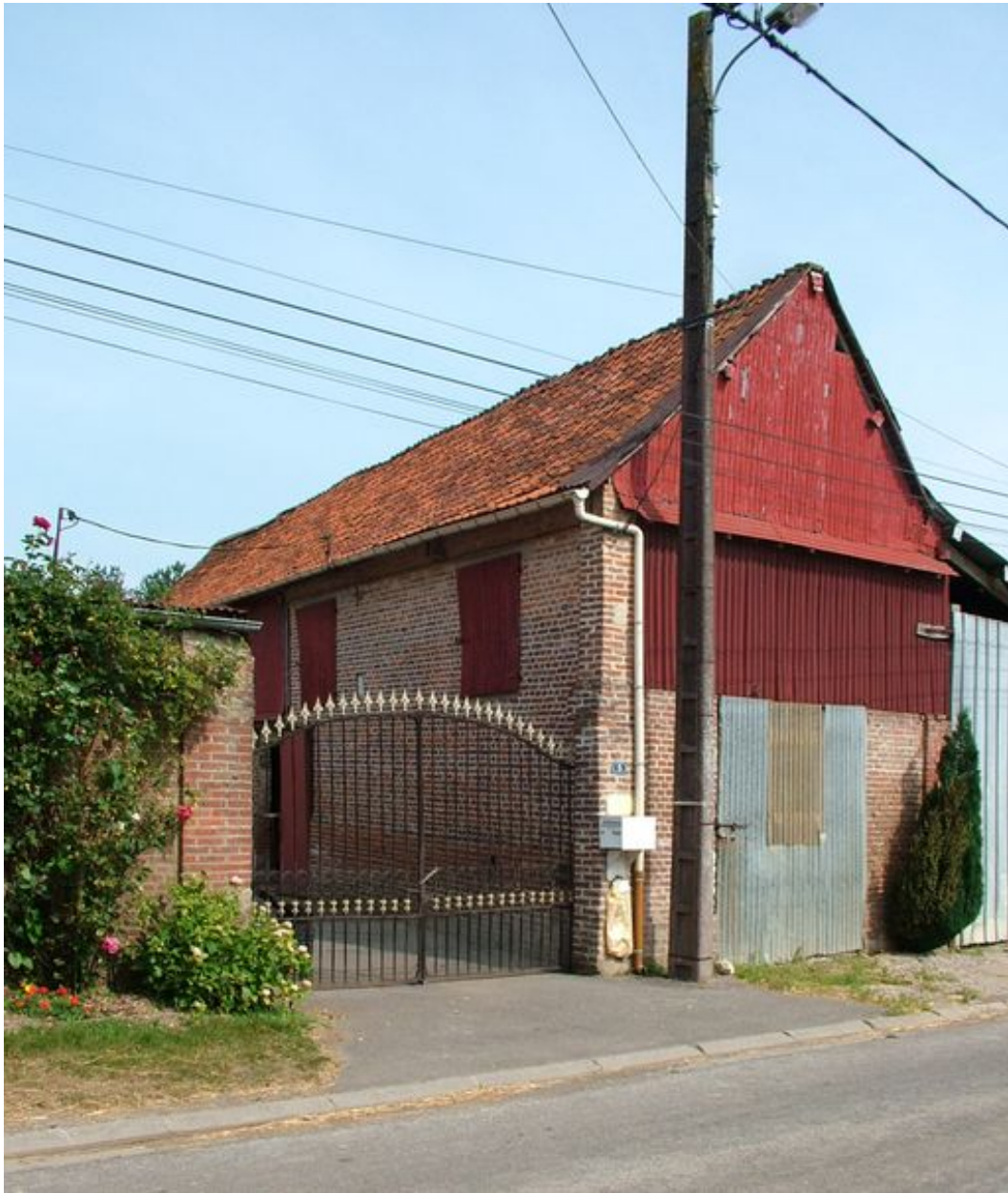
Vue générale depuis la rue : portail et grange.
