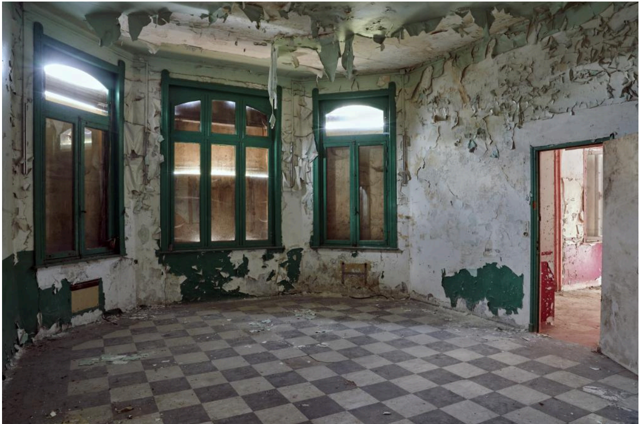
Vue intérieure d'une des chambres du rez-de-chaussée du logement du chef d'élevage.
