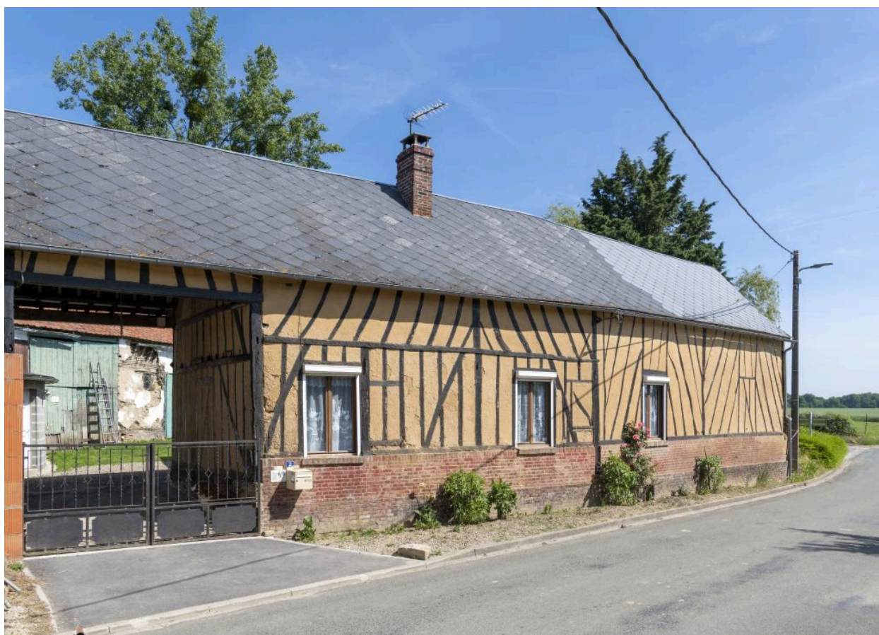
Logis de ferme sur rue, n°2 rue d'En Bas.
