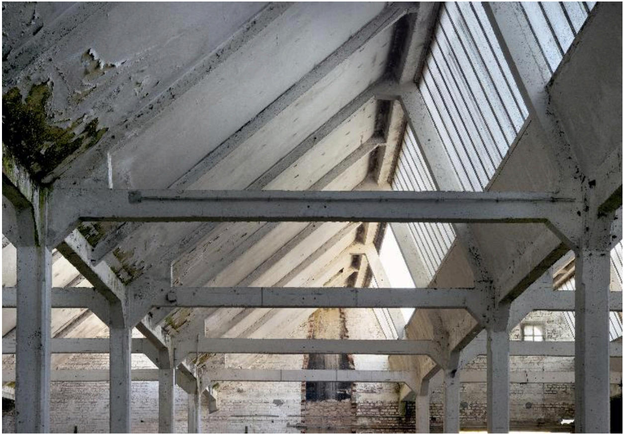
Détail de la charpente en béton armé de l'atelier de tissage.
