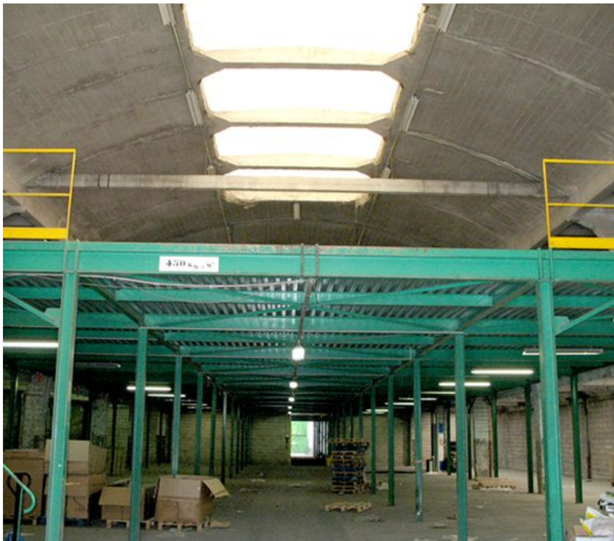
Intérieur de la fonderie construite par Perret.
