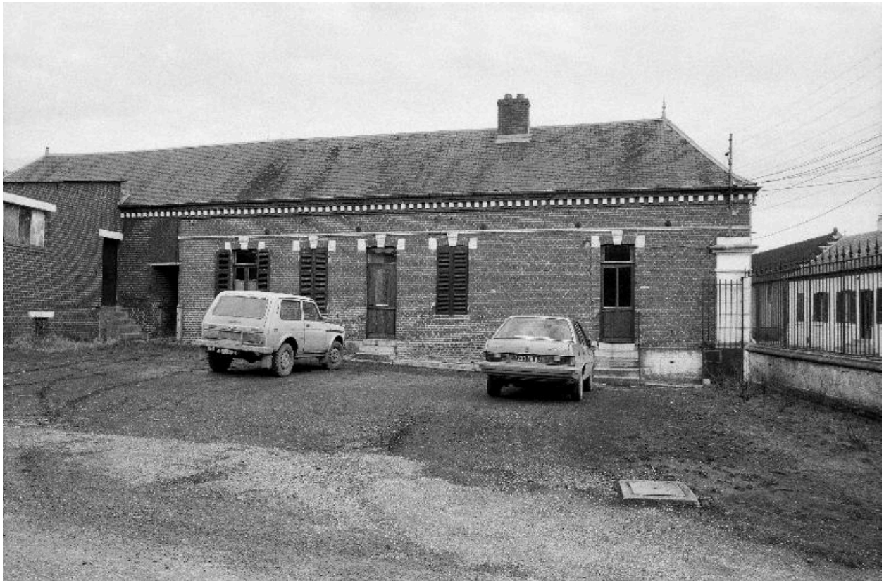
Bureau, conciergerie. Élévation antérieure.
