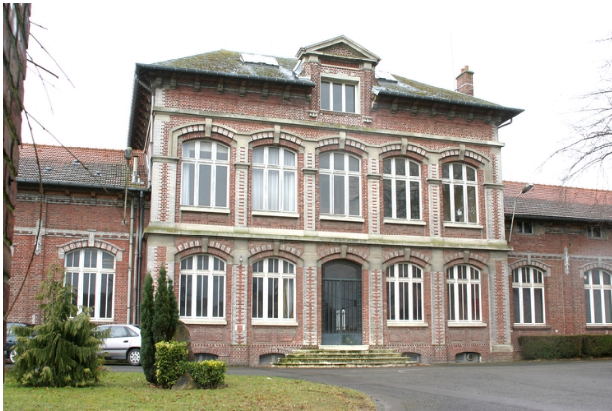
Façade antérieure des anciens bureaux.
