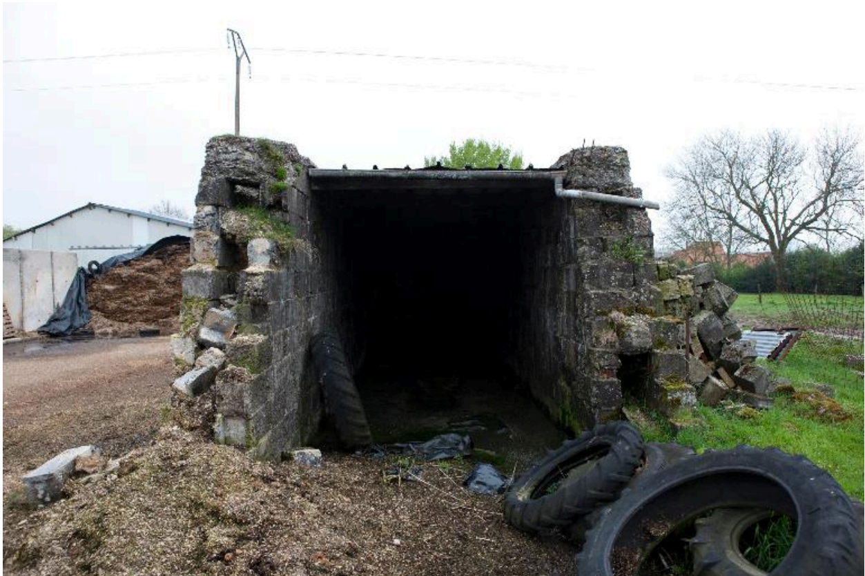
Vue de détail du premier abri de stockage en forme de ski.
