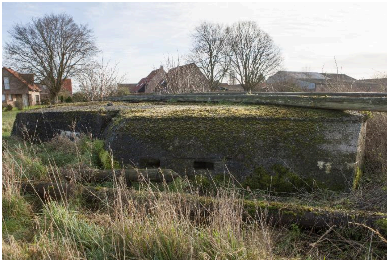
Casemate B : Elévation ouest. A gauche deux créneaux de fusillade ou d'observation.
