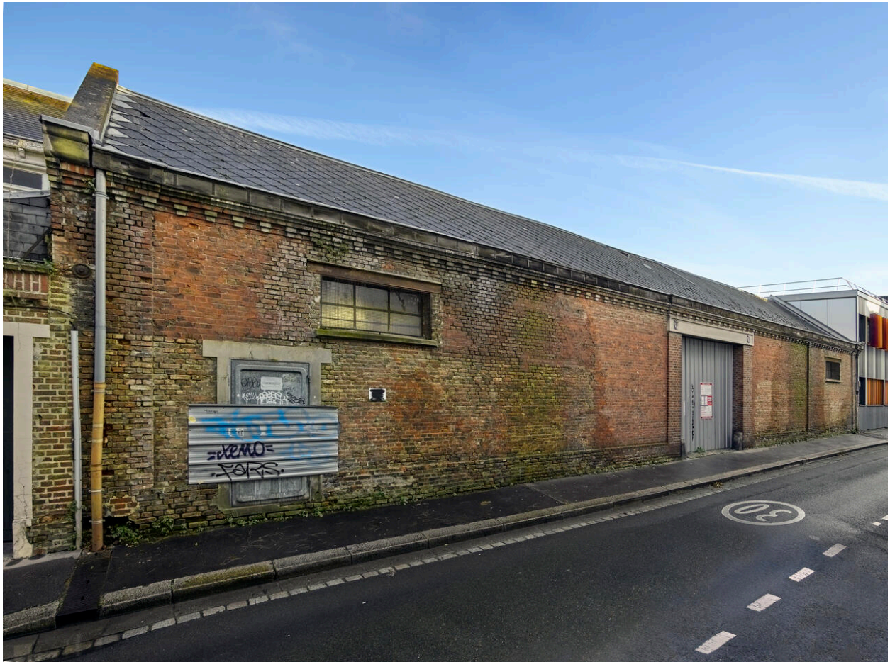
Vue générale de l'entrepôt rue Duthoit (en fond de parcelle). Vue prise depuis le sud-ouest.
