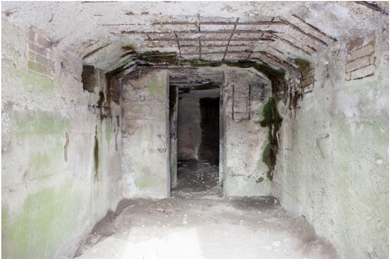
Vue intérieure en enfilade, vers le nord-ouest
