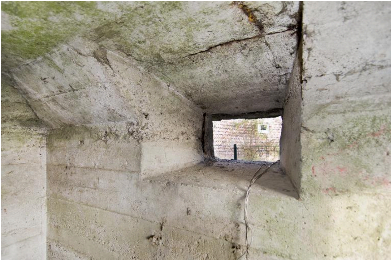
Guérite casematée (Bat. A). Vue intérieure de l'ouverture située dans l'élévation est
