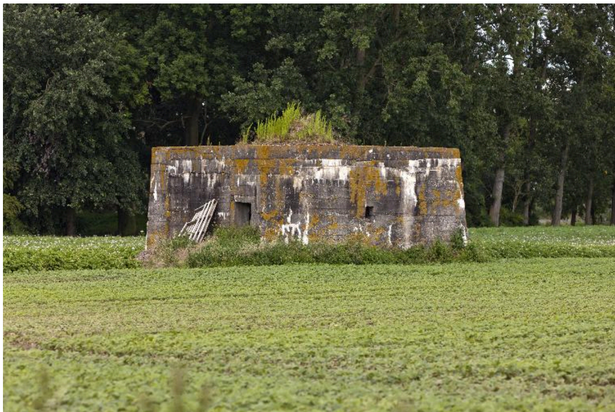
Vue vers le nord-ouest
