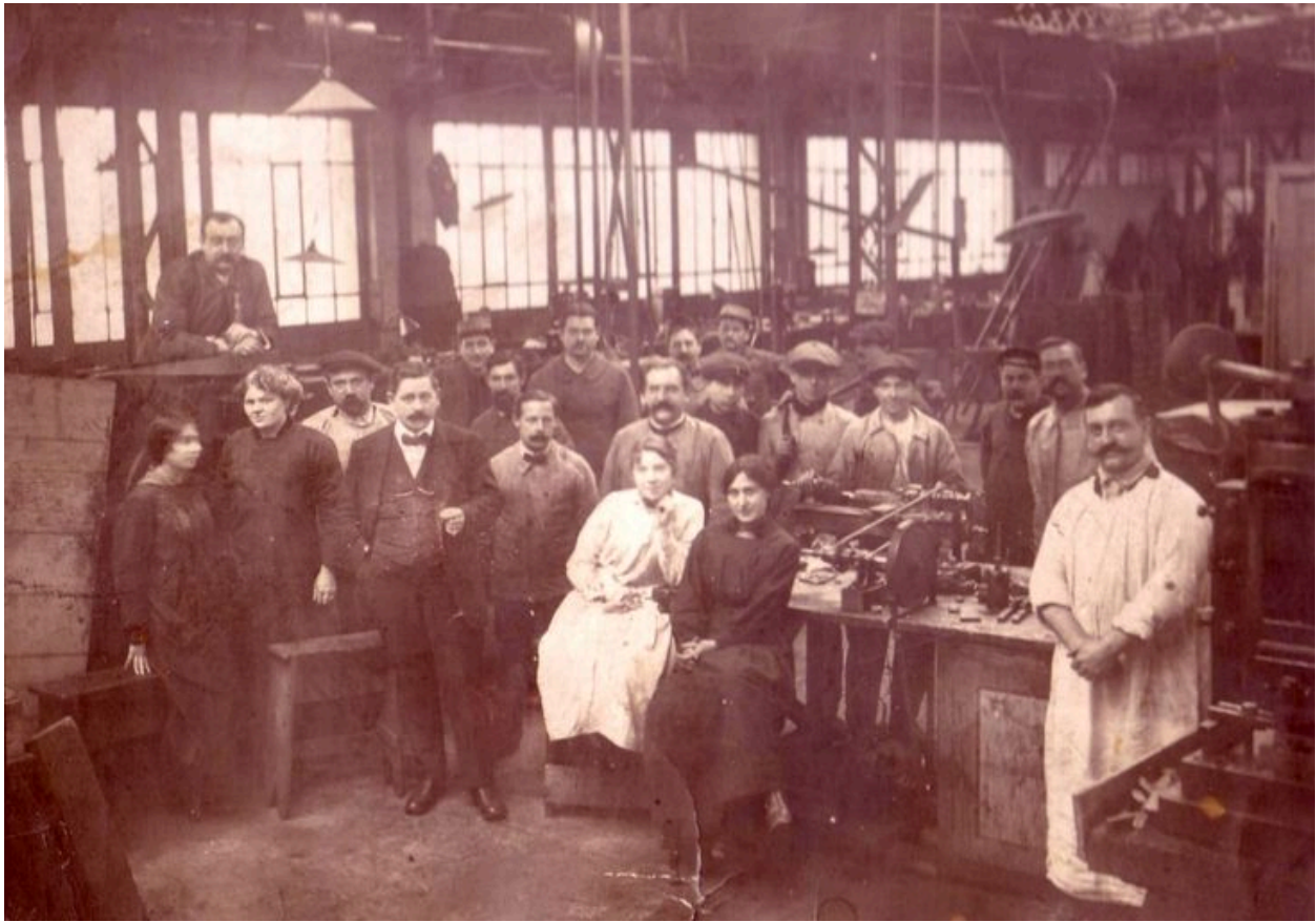
Vue intérieure de l'usine électrique, vers 1900 (AP).
