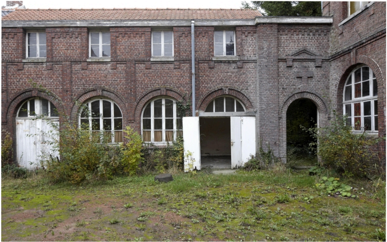
L'accès au jardin, entre les communs et le bâtiment sud.
