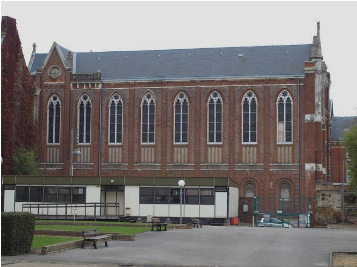
Chapelle : vue latérale
