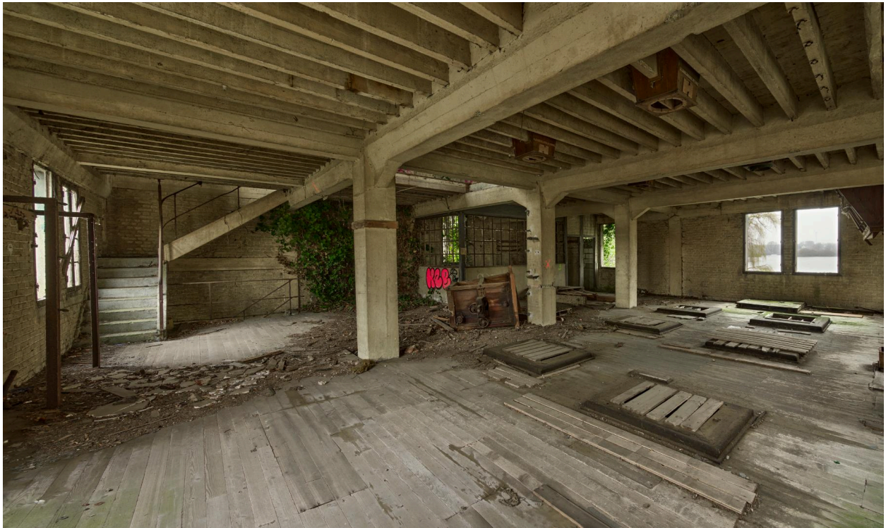
Intérieur du deuxième étage de la minoterie.
