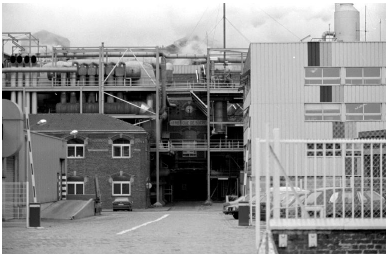
Entrée principale, bureaux et ateliers de fabrication.
