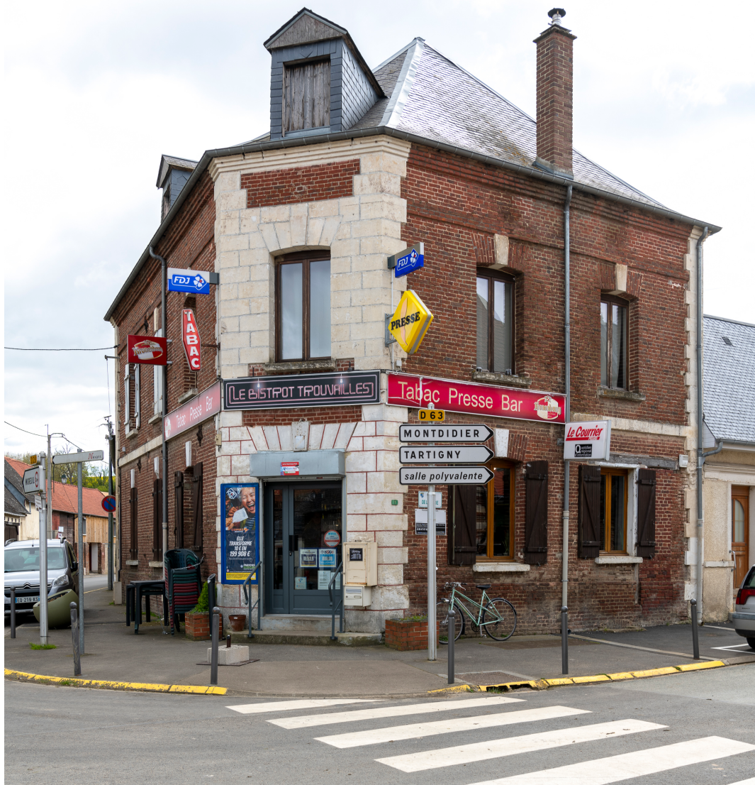
Café, n°1 rue de la Mairie, vue depuis le nord-ouest.
