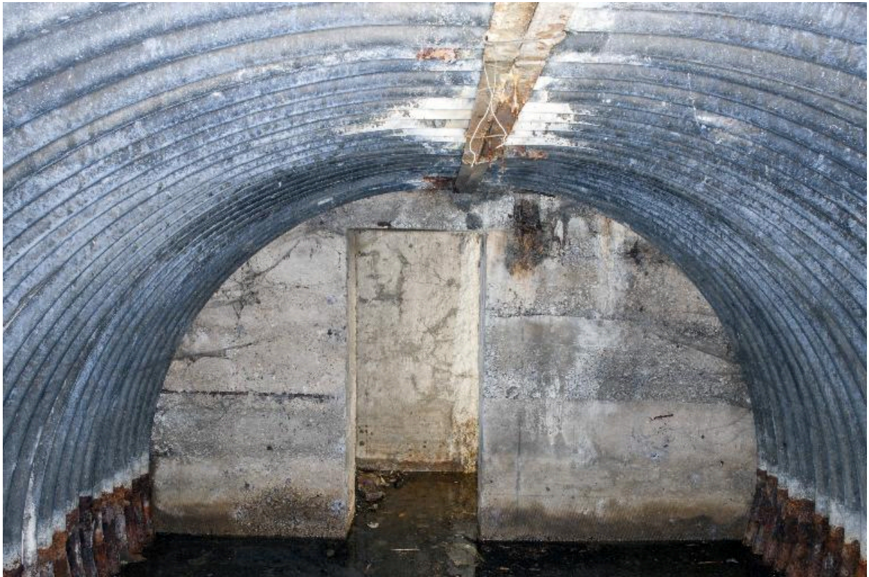
L'abri à personnel, vers le couloir
