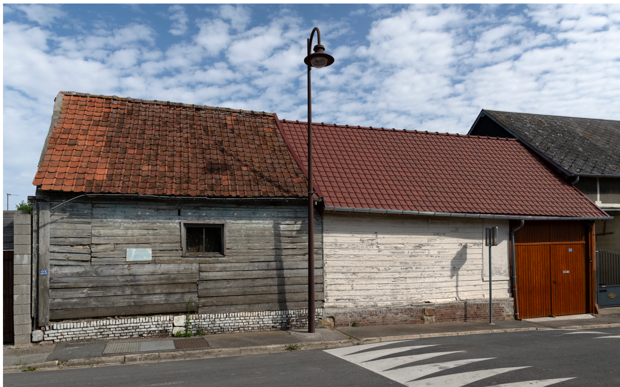
Deux granges sur rue, n°23-25 de la rue Roland-Mariage, vue prise depuis le sud.
